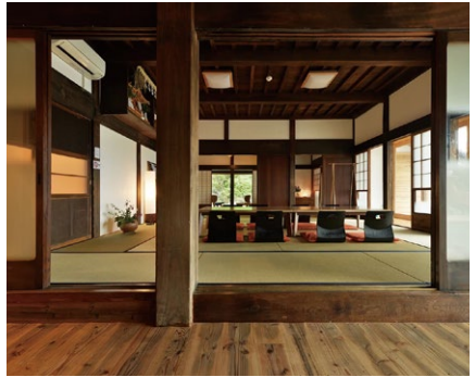
昔ながらの梁や柱を残した座敷
