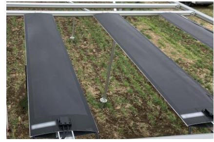
設置完了したペロブスカイト太陽電池
