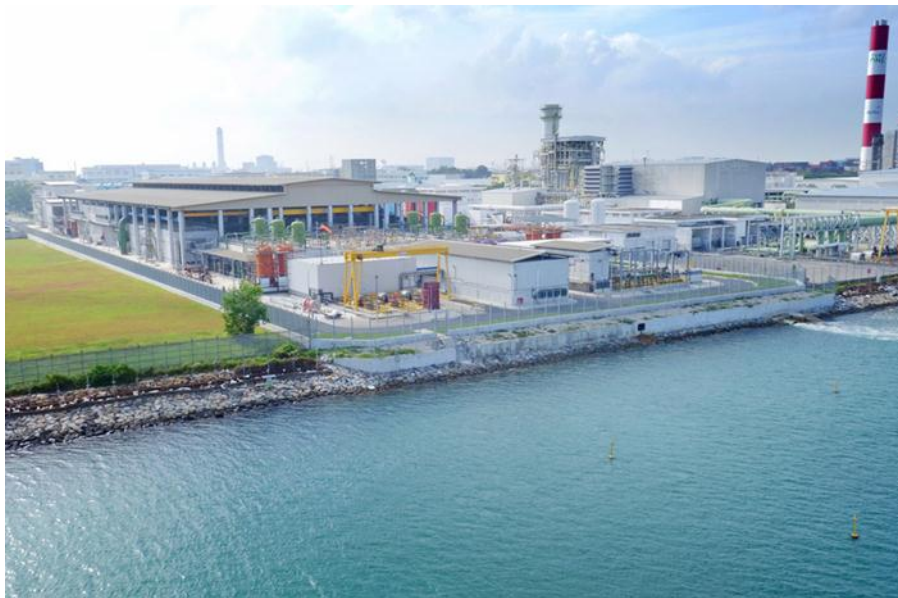
(トゥアス海水淡水化プラント 出所：PUB のHP より抜粋)
